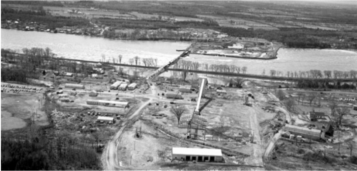
Préparation à la construction du barrage de Carillon en 1959.
